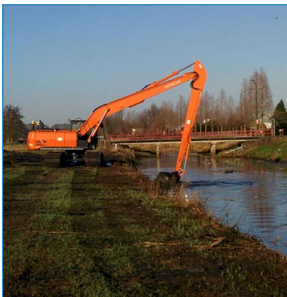
Baggeren met een grijperkraan vanaf de kant
