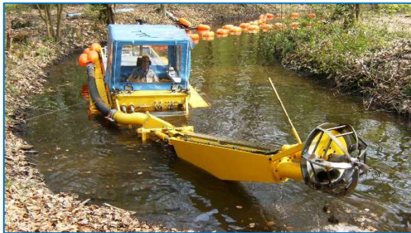
Hydraulisch baggeren met een cutterzuiger
