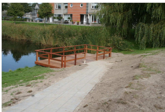
Foto: vissteiger van gerecycled kunststof Toepasbaarheid: bij oever met scherp talud
