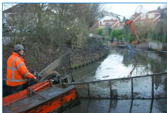
Baggeren met een duw- of schuifboot
