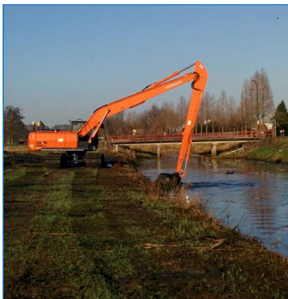
Baggeren met een grijperkraan vanaf de kant
