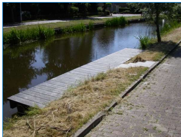
Foto: gerecycled kunststof; Toepasbaarheid: bij smalle oevers en watergangen
