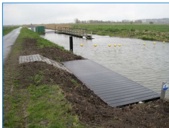
Foto: gerecycled kunststof; toepasbaarheid: oever met scherp talud
