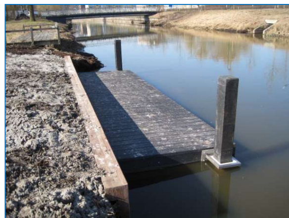
Foto: gerecycled kunststof (drijvende vlonder); Toepasbaarheid: bij wisselend waterpeil
