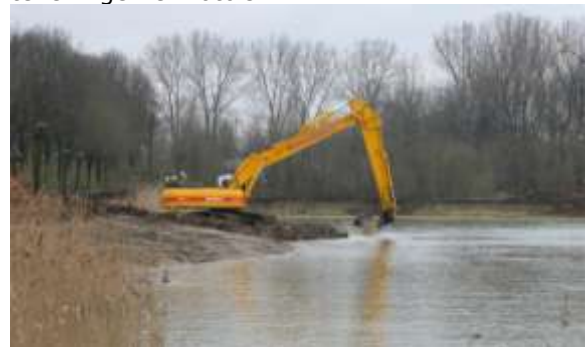
Herinrichtingswerkzaamheden aan de oever
