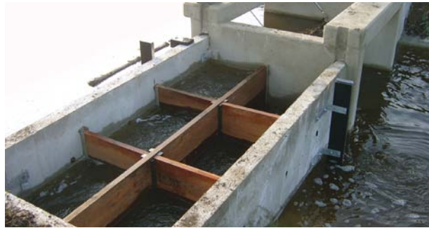
Door het compacte ontwerp van de vispassage is deze ook in kleine watergangen aan te leggen.
