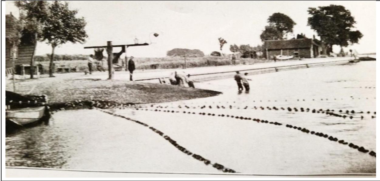
Zalmvisserij Klein Profijt II (Oude Maas), een van de grote, gemechaniseerde zalmzegenvisserijen. De zegenkade had een lengte van circa 1 km, de 'haalbollen' zijn goed zichtbaar. De zegen wordt in gedeelten binnengehaald. De stoomspil bevond zich bij de gebouwen op de achtergrond. (foto: Verslag Staatscommissie Zalmvraagstuk, 1916)
